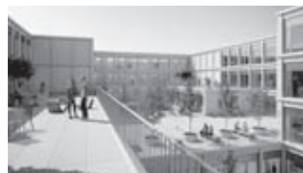
Chacun des deux bâtiments du CFPS et du CO s'organise autour d'un patio généreux, qui s'échelonne en terrasses offrant des dégagements extérieurs sur plusieurs niveaux.
