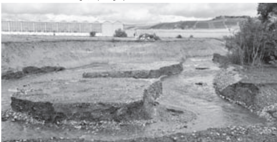
L'Aire avec ses nouveaux losanges, déjà rongés par la 1 ère crue du 4 octobre 2021. Photo du 5 octobre 2021
